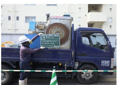
舗装切断水処理車 上プラントの設置
