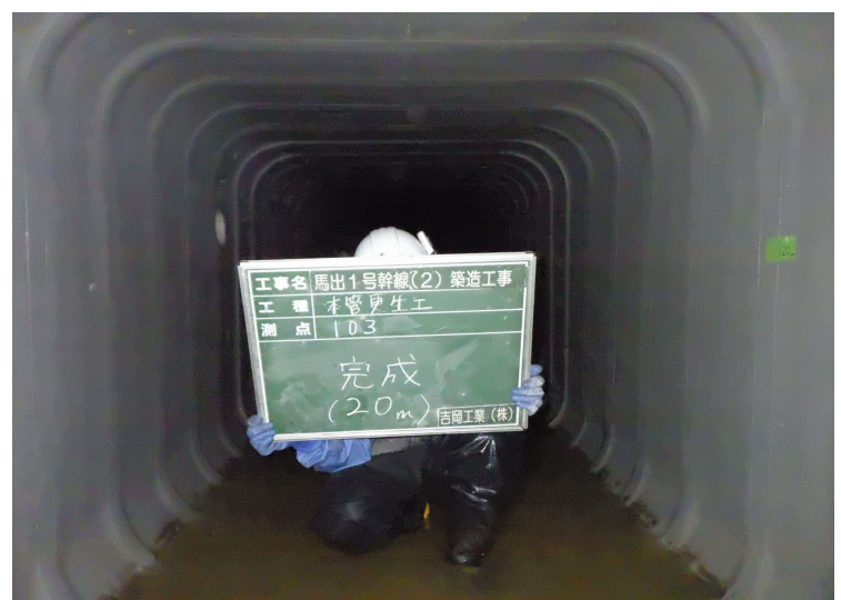
完 成（更生後：クリアフロー工法）
